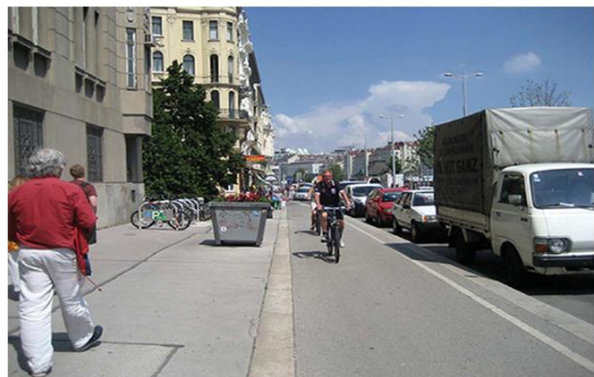
Ποδηλατόδρομος μονής κατεύθυνσης στο επίπεδο του πεζοδρομίου
