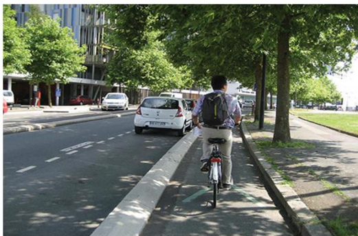
Ποδηλατόδρομος μονής κατεύθυνσης στο επίπεδο του οδοστρώματος, δίπλα σε ζώνη παρόδιας στάθμευσης και διαχωρισμένος με ειδικού τύπου κράσπεδο
